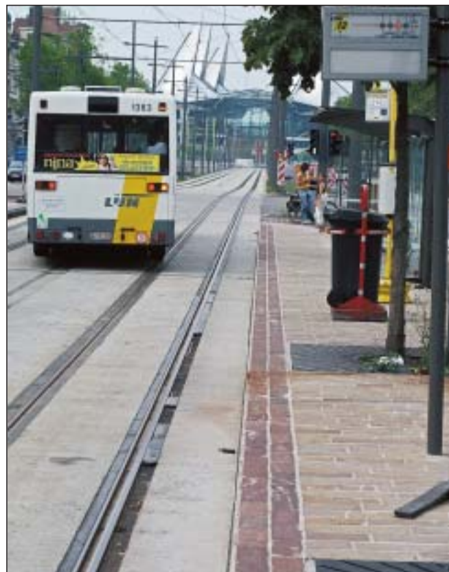
De vrije baan op de Amerikalei. Dat de sporen niet werden ingegoten zoals het hoort, is duidelijk te zien. Gva-foto Jan VAN DER PERRE
